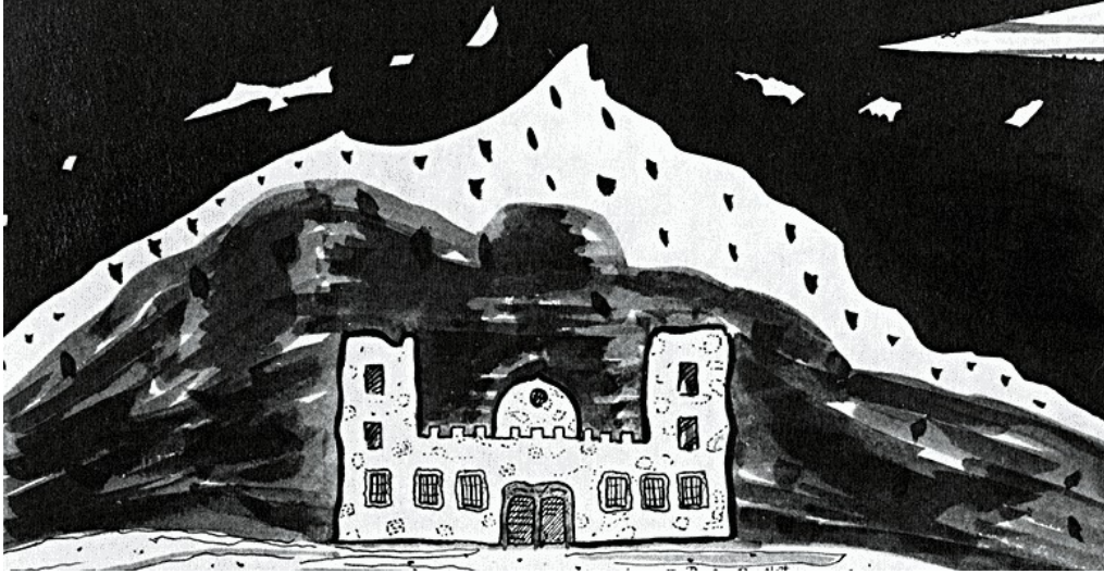
Hacienda de Endo. Sonora: residence, stable below.
