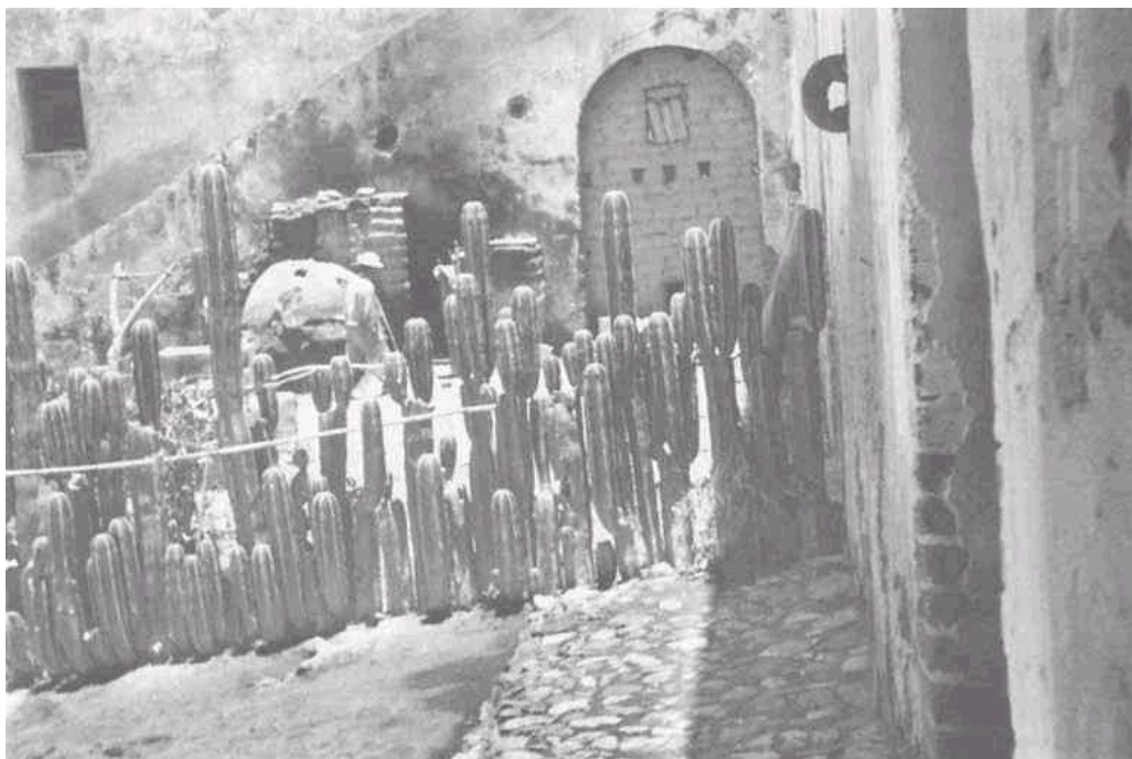
Hacienda de Xotla, Puebla: residence patio and oven.
